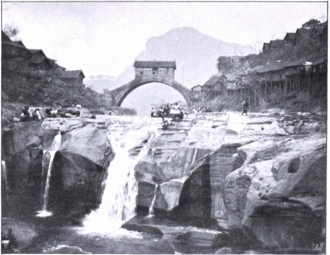
BRIDGE AT WAN HSIEN, SZECHUAN.
